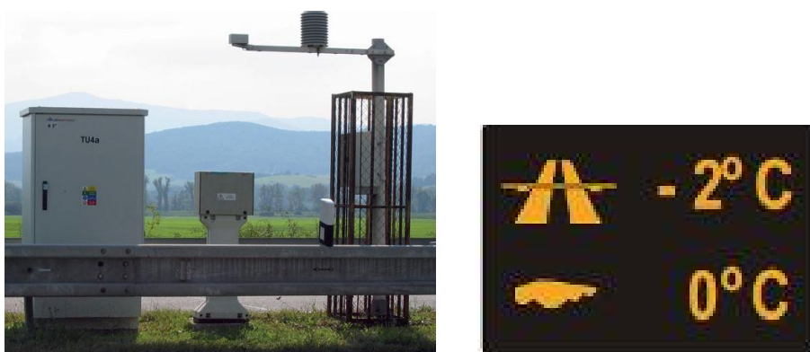
Obr. 4 Meteorologická stanica a informácie o teplote vozovky vzduchu
