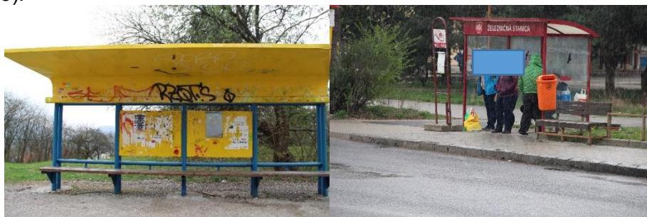
Obr. 5 Príklad stavu a rôzneho technického riešenia prístreškov vo vybranej MHD Zdroj: Autori a [17]
