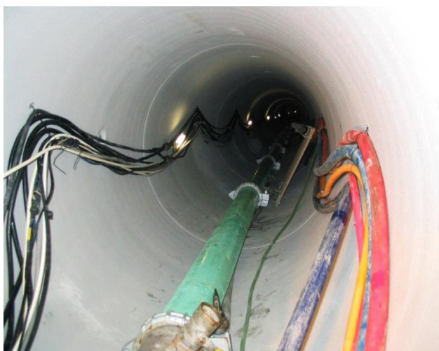
Obr. 6 Příklad vtačovaného potrubí z Japonska. Max. odzkoušený průměr 3 m. Foto autor
