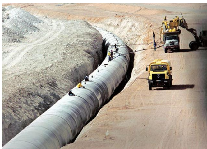
Obr. 8 Doprava vody v Libii potrubím v poušti o délce 1600 km a průměru potrubí 4 m. Zdroj: J. Kotulič Bunta
