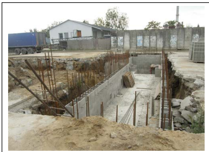
Obr. 3 Základy betonárky
