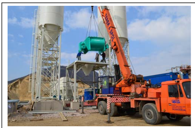
Obr. 5 Montáž na mieste – montáž miešacieho jadra
