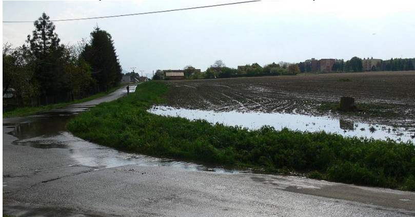
Obr. 3 Silnice poškozené mimořádnou událostí pouze minimálně
