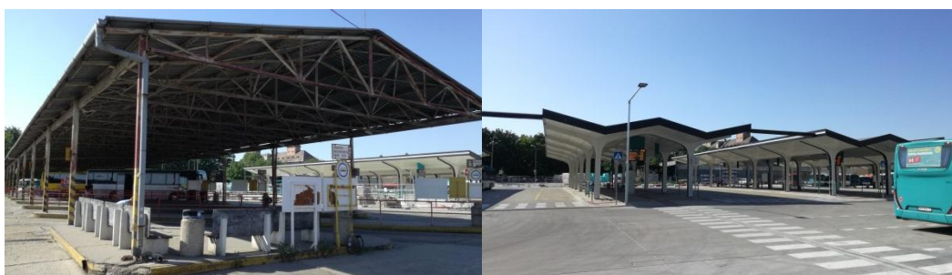
Obr. 2 Príklad prestavby autobusovej stanice v Nitre (vľavo nerekonštruovaná časť; vpravo po rekonštrukcii); Zdroj: Autori
